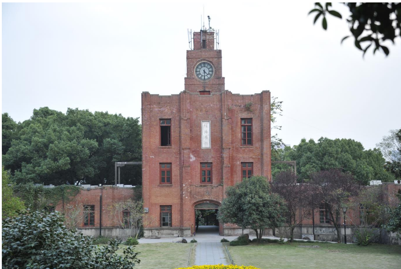
杭州之江大学旧址钟楼（国家级文物）外立面修缮设计（2014-2015）
